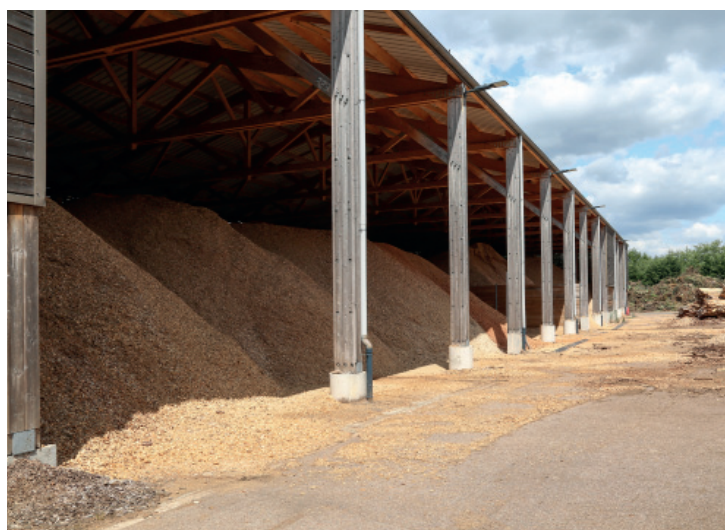
Plateforme de stockage de plaquettes bois - Château-Chinon
