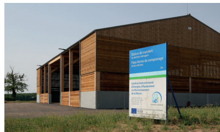
Plateforme de stockage de plaquettes bois - Rix
