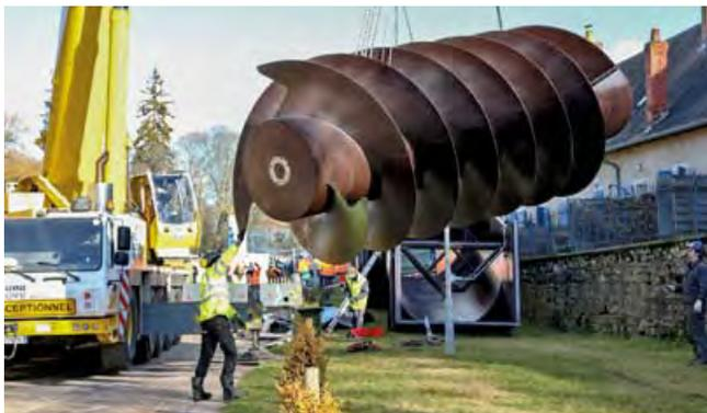
Installation de la vis de la centrale hydroélectrique située sur le site des Forges Royales de Guérigny
